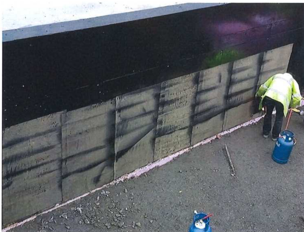
Izolácia rámového priepustu - SO 12-33-05
