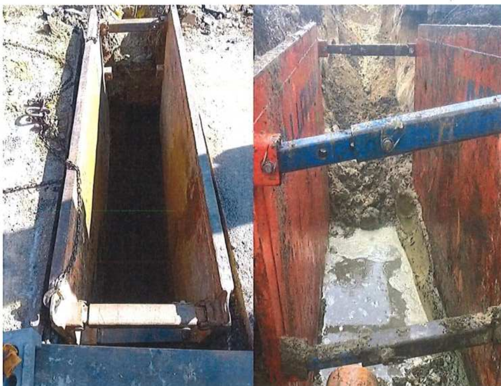
Paženie výkopov - SO 11-37-05.1 a SO 11-37-06.1
