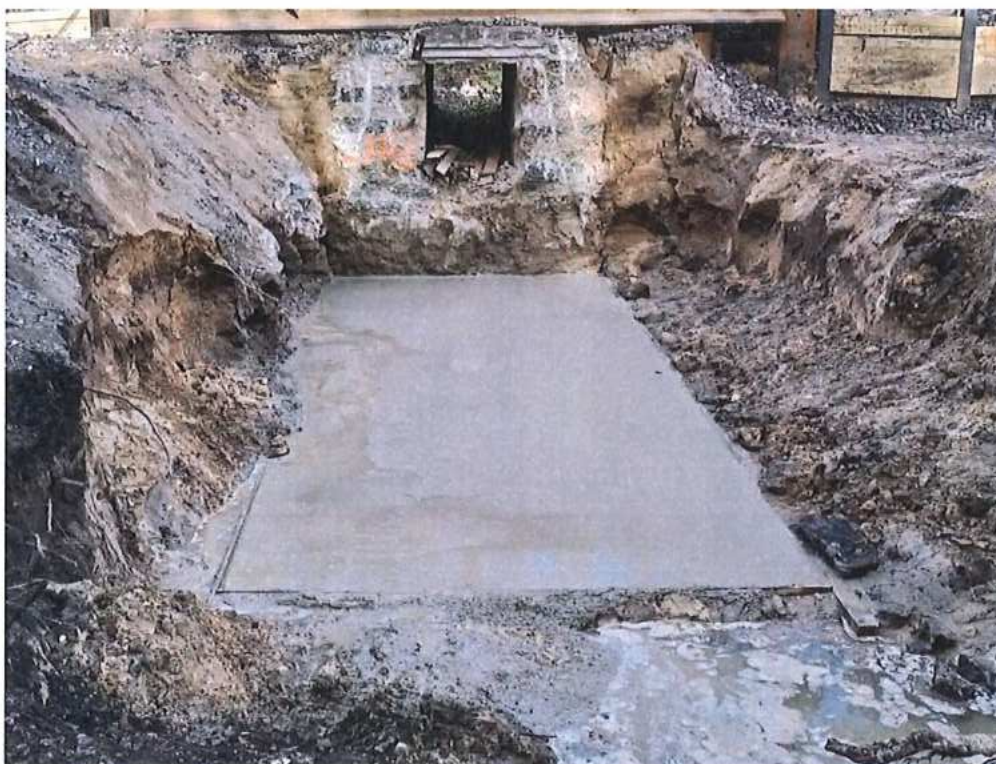
Betonáž podkladného betónu – SO 10-32-07
