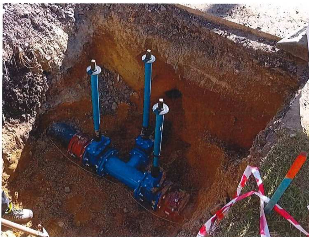
Prepoj vodovodu v Brodskom - SO 11-37-05
