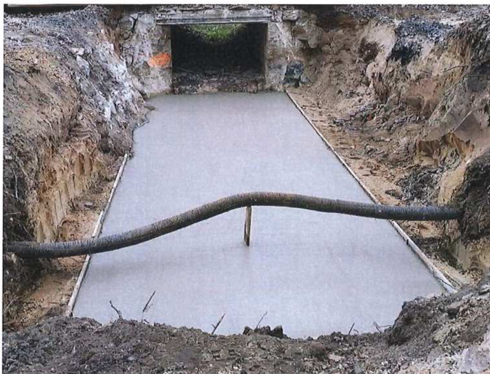
Betonáž podkladného betónu – SO 10-32-06
