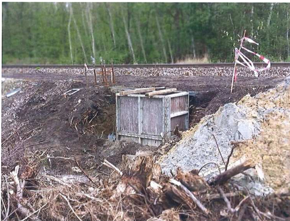
Betonáž základov TP – SO 10-35-01
