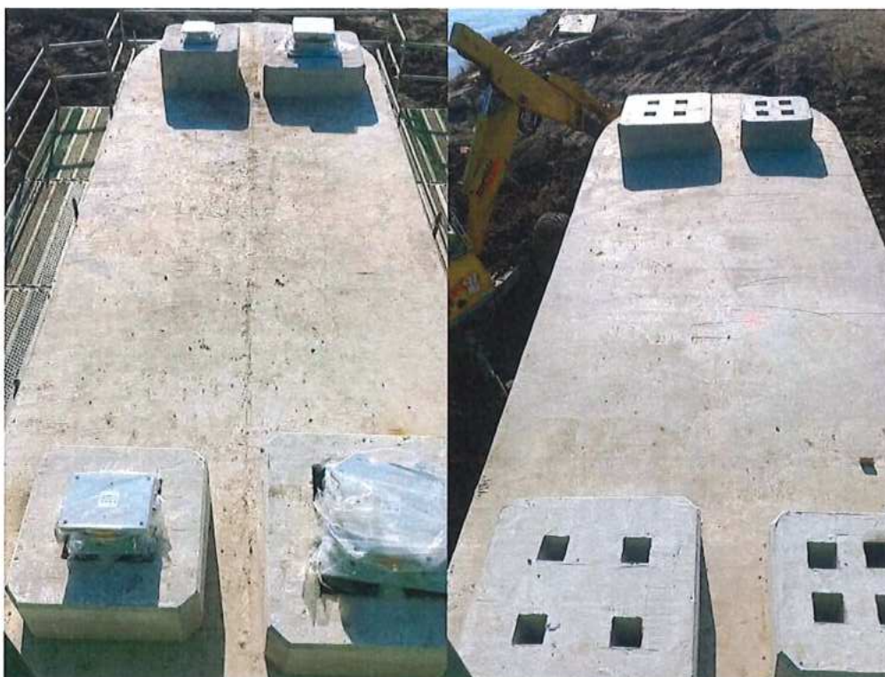
Príprava na montáž ložísk - SO 12-33-04
