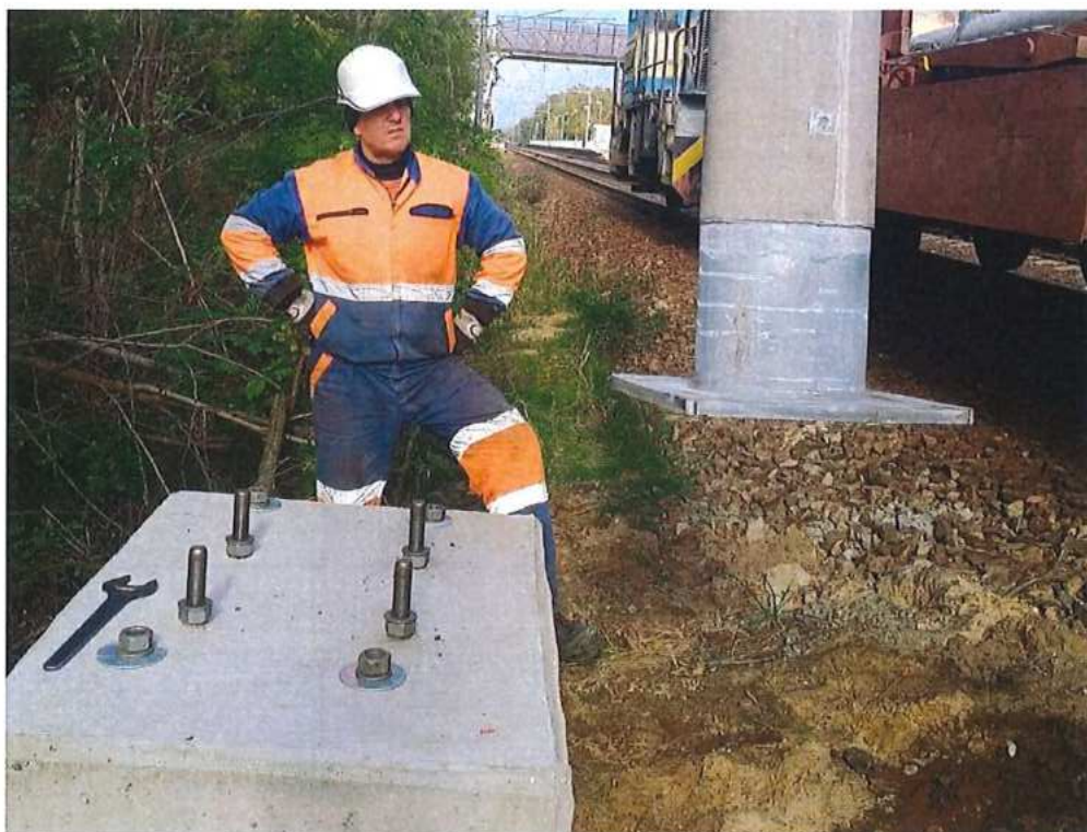
Montáž trakčných podpíer pri 1.TK - SO 01-35-01
